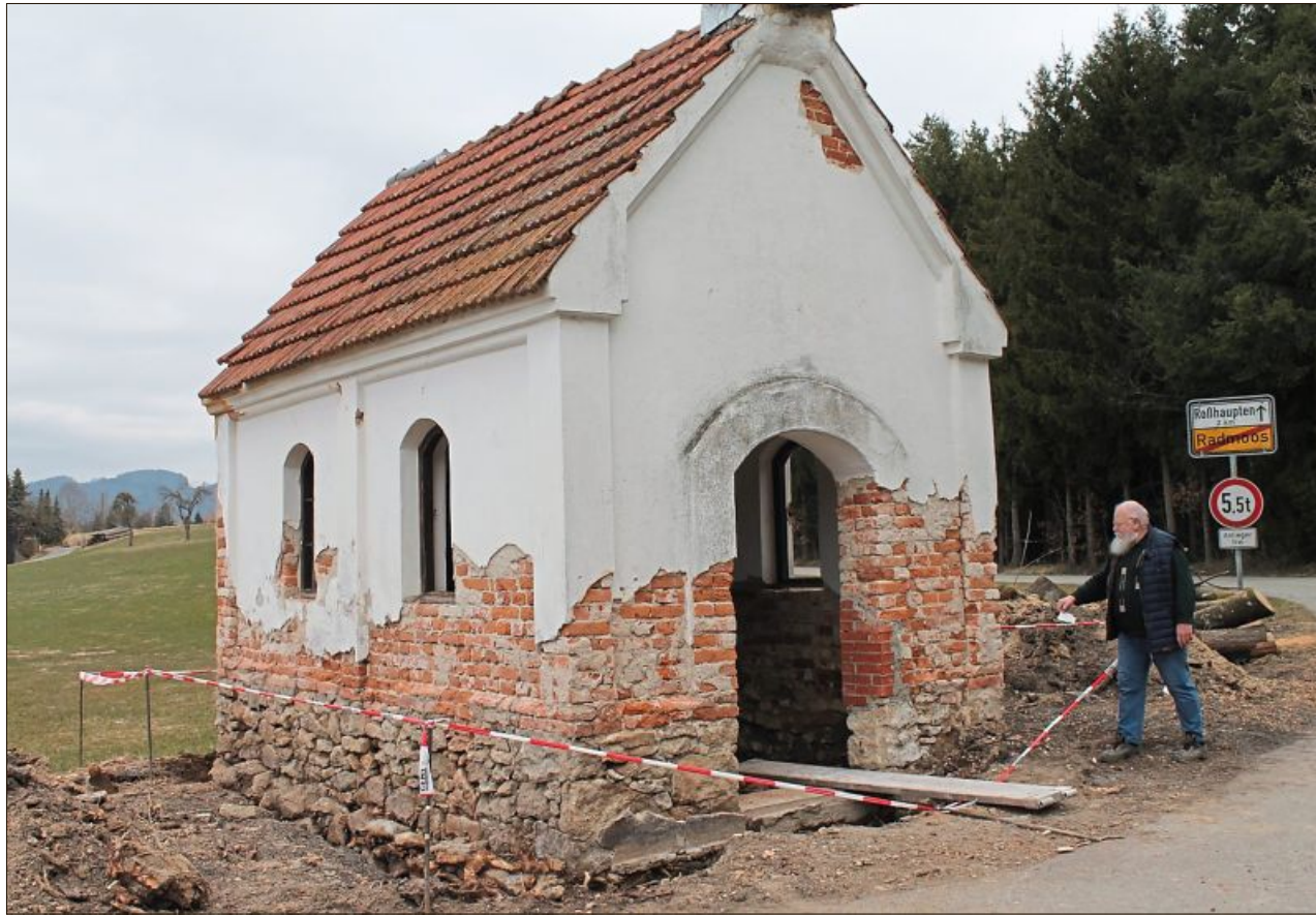
Inzwischen wird die Kapelle saniert, hier Initiator Franz Rainer an der Baustelle.
